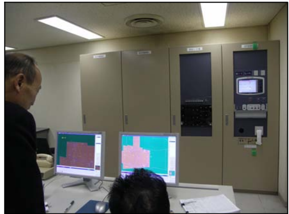
18年度 防災設備改修
